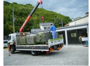
<補修ネットの搬入>
