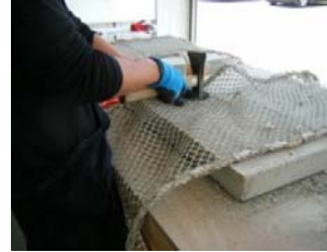
<補修ネットの付着物落とし>
