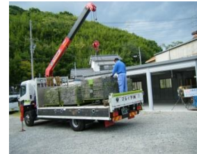
<補修ネットの搬入>
